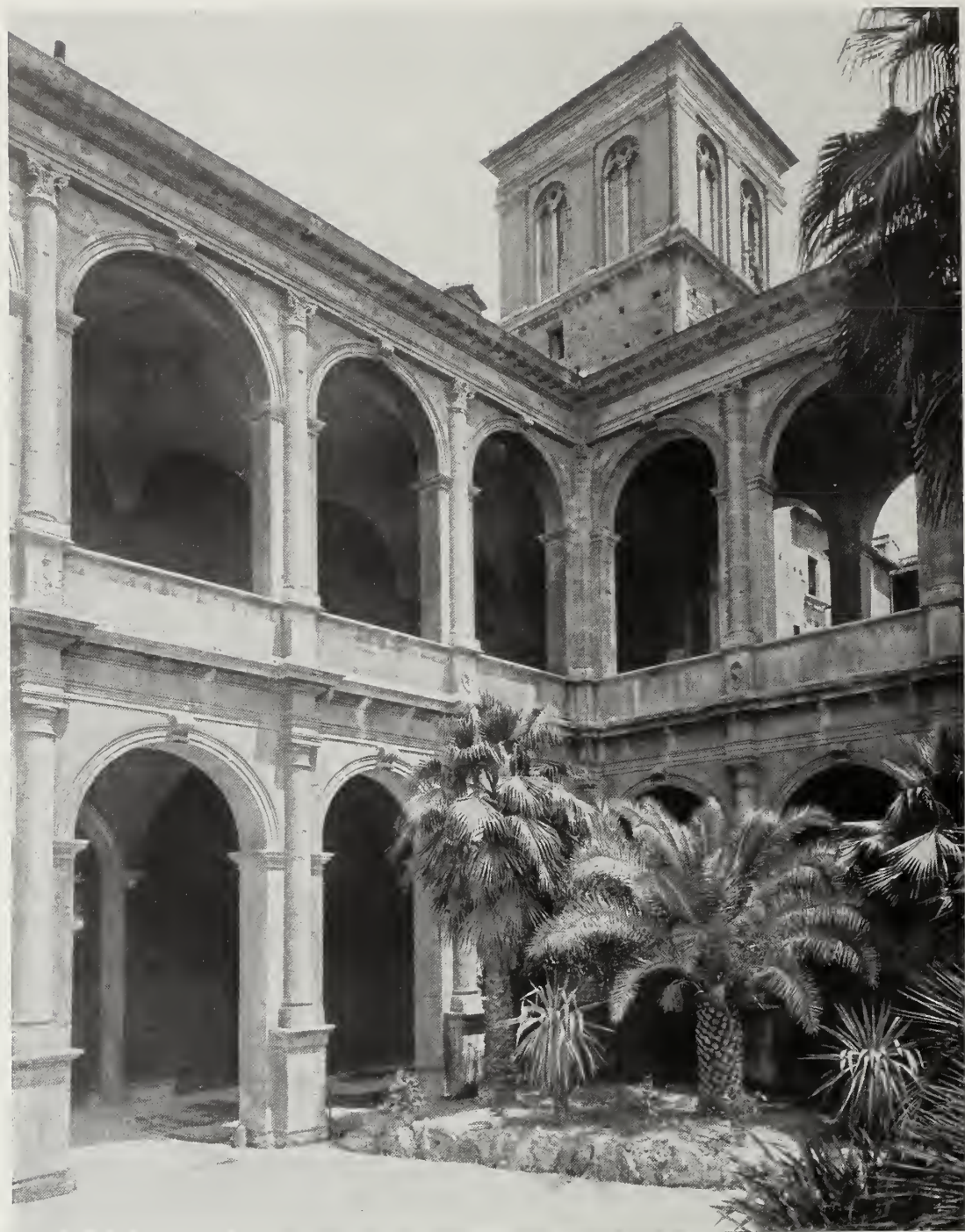
Hof des Palazzo di Venezia, Rom
